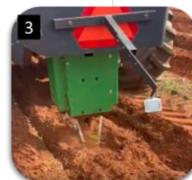
3 Levante do cabeçote ainda com sistema de irrigação acionado (para fechamento da cova)
